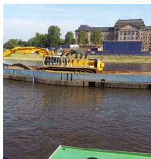
Ein Schwimmgreifer sorgt nach dem Niedrigwasser dafür, dass die Elbe wieder ihre gewohnte Tiefe hat. Foto: SachsenGAST
