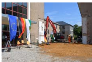
Am Montag erfolgte der erste Spatenstich für den Anbau am Barkhausenbau. Fotos (2): SachsenGASAT
